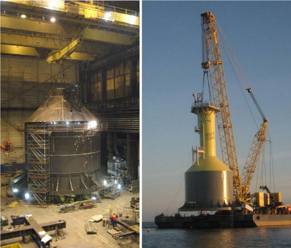
Tahkoluodon pilottivoimalan valmistusta ja asennus.
