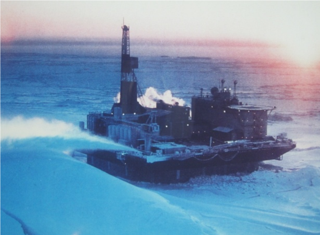
Öljynporaustasanne CIDS Beaufortinmerellä. Tämä pehmeällä pohjalla oleva massiivinen betonirakenne värähteli pelottavassa määrin jäiden vaikutuksesta. Kuvassa sen suojaksi rakennetaan pohjautunutta jääsaarta.
