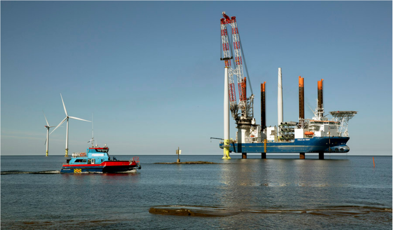
Tahkoluodon merituulipuiston rakentamista.
