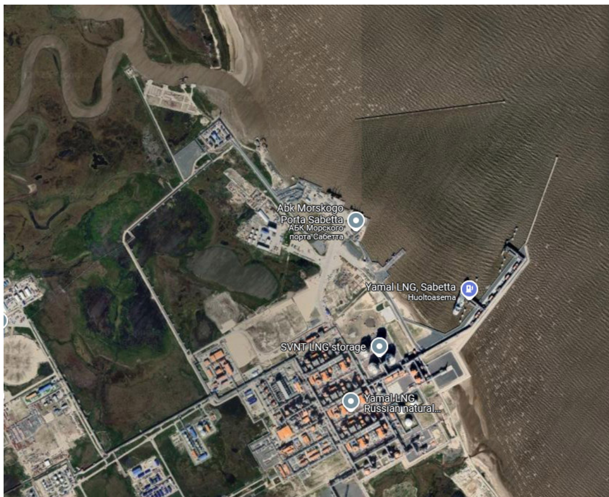
Ilmakuva Sabettan LNG-terminaalista ja satamasta.
