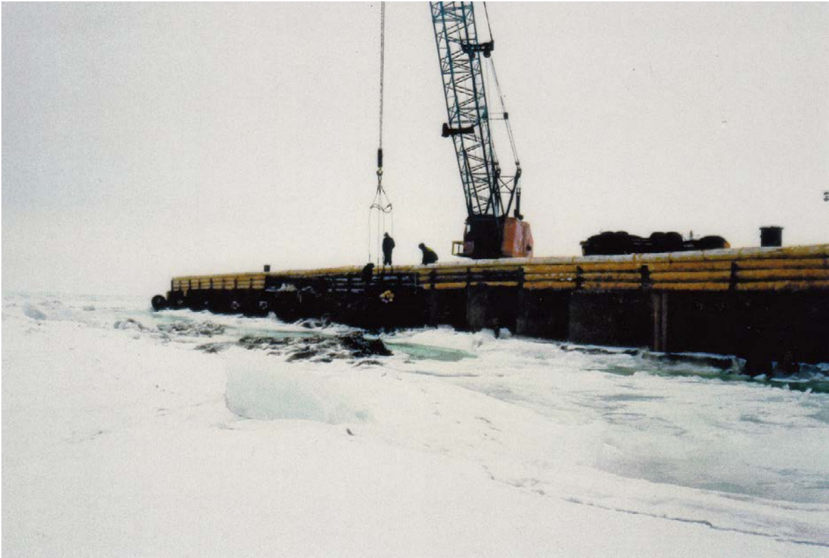
Laiturimuuri on rakennettu jatkuvaksi terässylinterien avulla.
