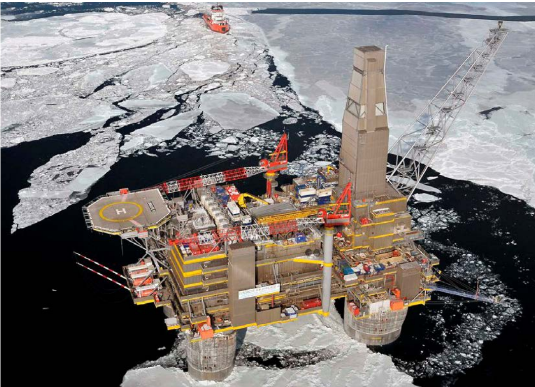
Myös öljynporaustasanne Ohotanmerellä värähteli jäiden vaikutuksesta. Aluksi jäänmurtaajat rikkoivat lähestyviä jäälauttoja ja myöhemmin rakennetta korjattiin.
